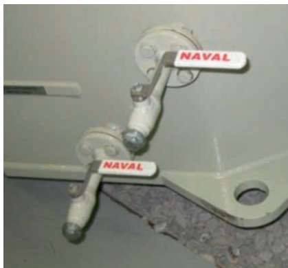
図9. 水分センサの推奨されない取り付け位置。変圧器タンク底部近くにあるオイル試料コネクタ(左)、拡張タンク(右)
