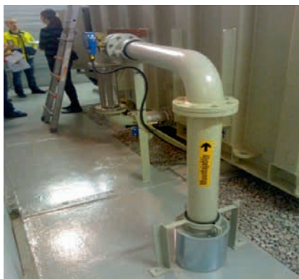
図8. 水分センサの推奨取り付け位置。オイル冷却循環ライン(左)は強制循環と自由循環のどちらの冷却を実施する場合にも理想的な計測場所です。また、変圧器タンク(右)の外壁からの取り付けも適切な計測場所です。
