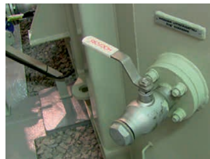
図8. 水分センサの推奨取り付け位置。オイル冷却循環ライン(左)は強制循環と自由循環のどちらの冷却を実施する場合にも理想的な計測場所です。また、変圧器タンク(右)の外壁からの取り付けも適切な計測場所です。
