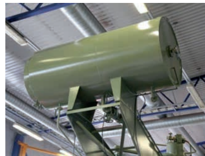
図9. 水分センサの推奨されない取り付け位置。変圧器タンク底部近くにあるオイル試料コネクタ(左)、拡張タンク(右)
