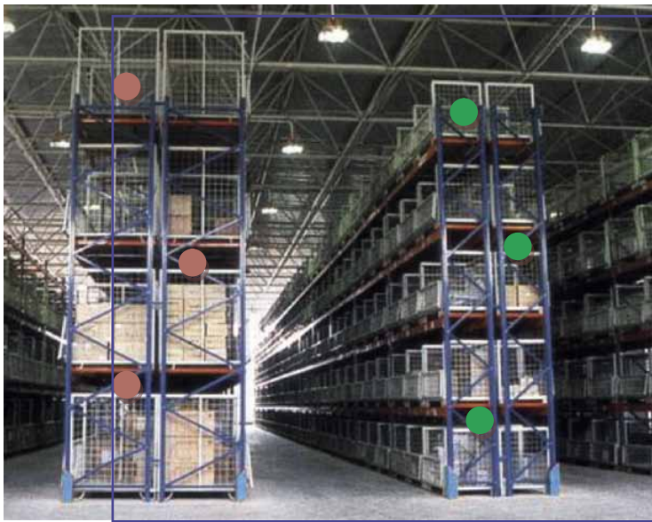
Figure 2. Les capteurs placés au milieu des racks reflètent les températures effectives des produits. Dans cet exemple, neuf capteurs sont placés sur chaque double rack dans un entrepôt de 30 mètres par 30 mètres sur 15.
