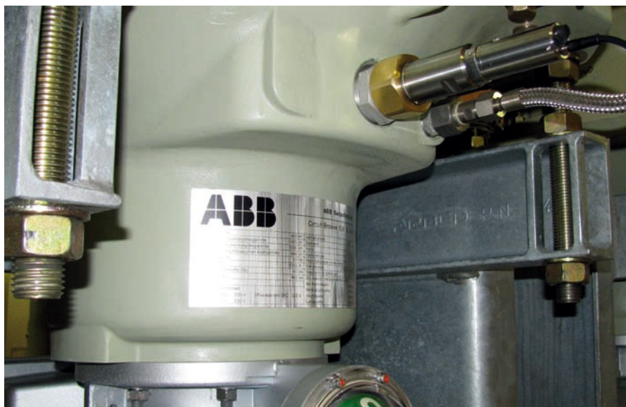
図5: 本体のガスタンクに直接取り付けられた、露点・圧力・温度センサ (DPT145) (2010年3月25日～4月14日)。計測セル内のガス量は約20ml。
