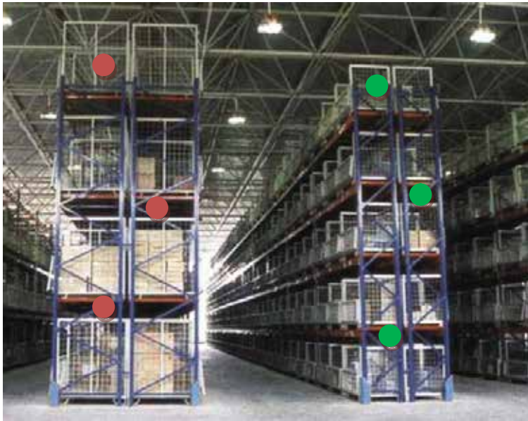
Abbildung 2: Sensoren in der Mitte von Regalen spiegeln Produkttemperaturen besser wider. In diesem Beispiel sind neun Sensoren in jedem Doppelregal in einem Lagergebäude mit den Abmessungen von 30 x 30 x 15 Metern angeordnet.
